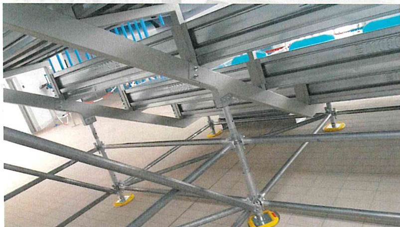
FIG.2 __ PARTICOLARE COSCIALE & RETRO STRUTTURA DEL MODULO RAMPA.
