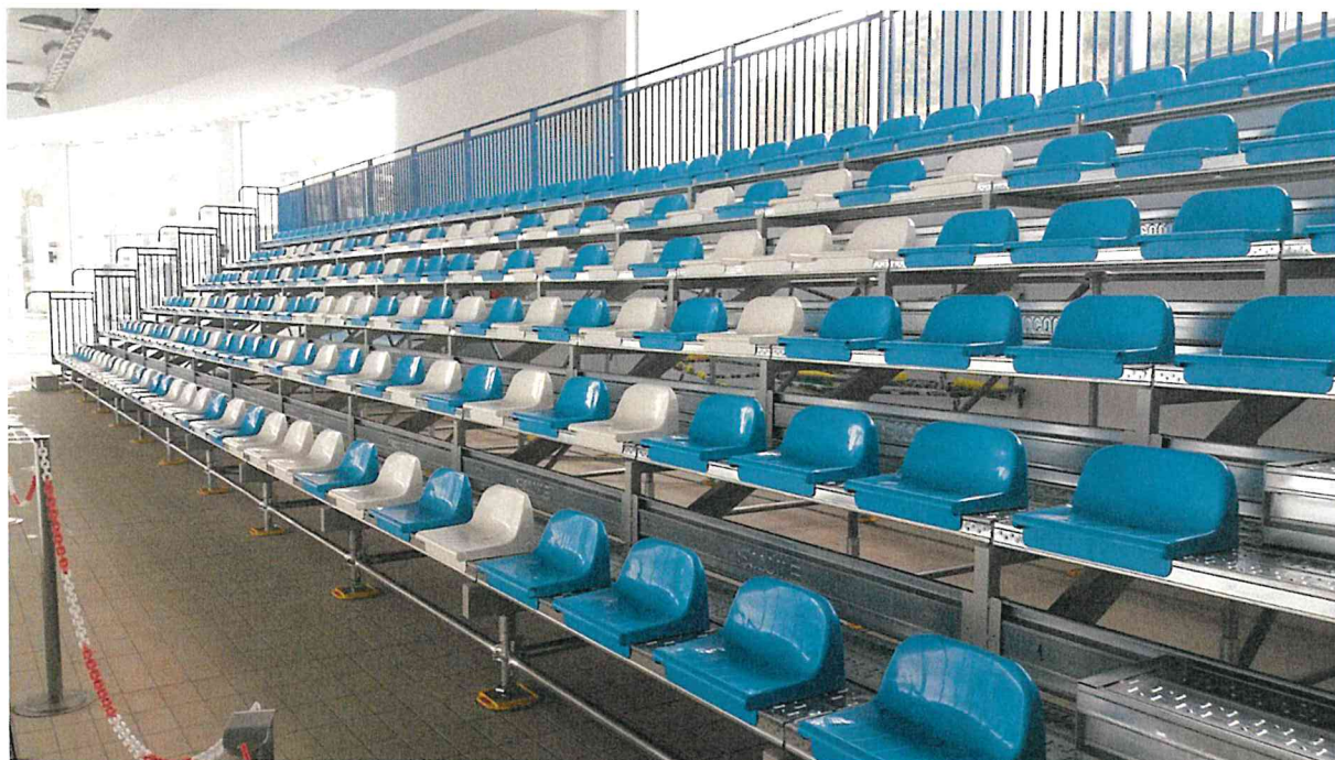
FIG.1 __ FRAME TRIBUNA MODULARE PREFABBRICATA 'SOCOME' STRUTTURATA CON SINGOLI MODULI RAMPA A 5 GRADONI CON SEDUTE MONOPOSTO [SEDIOLINI] & SCALE DI ACCESSO LATERALI.
